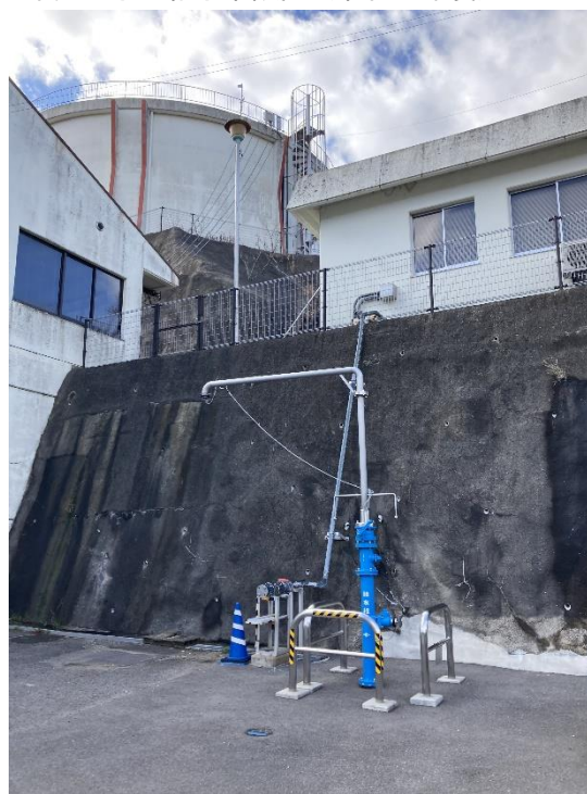
中央配水池給水塔設置（令和3年度）
