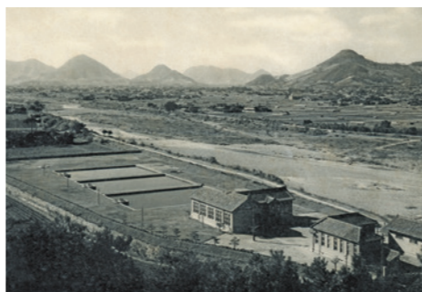
▲創建当時の御殿水源池
