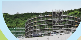
御殿配水池築造工事
