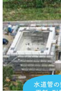
肥土山浄水場更新工事
