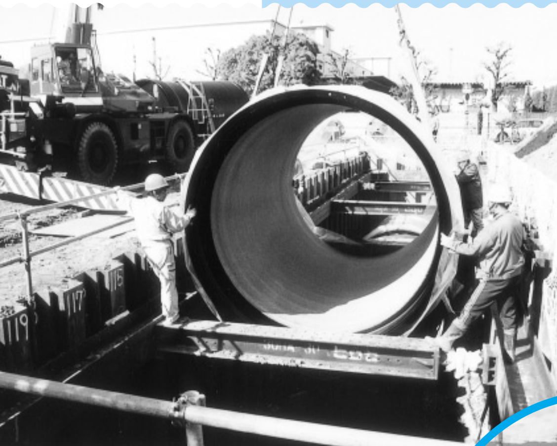
上：飲料水兼用耐震性貯水槽の設置工事 下：応急給水訓練 右下：配水管修繕訓練
