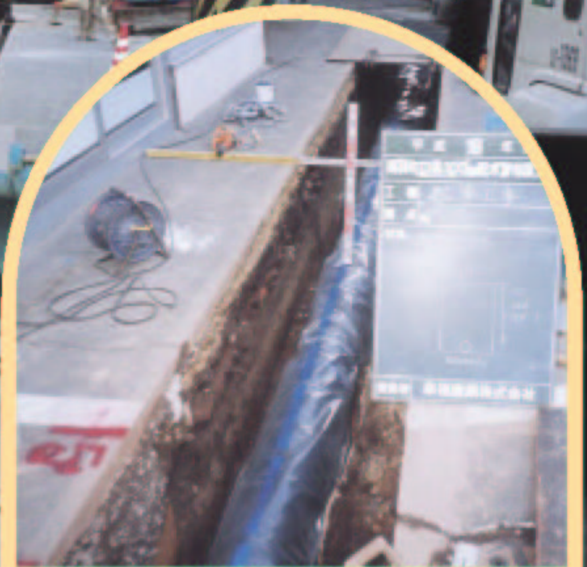
写真は、栗林町内での口径300mmの老朽配水管の布設替え工事の様子です。
