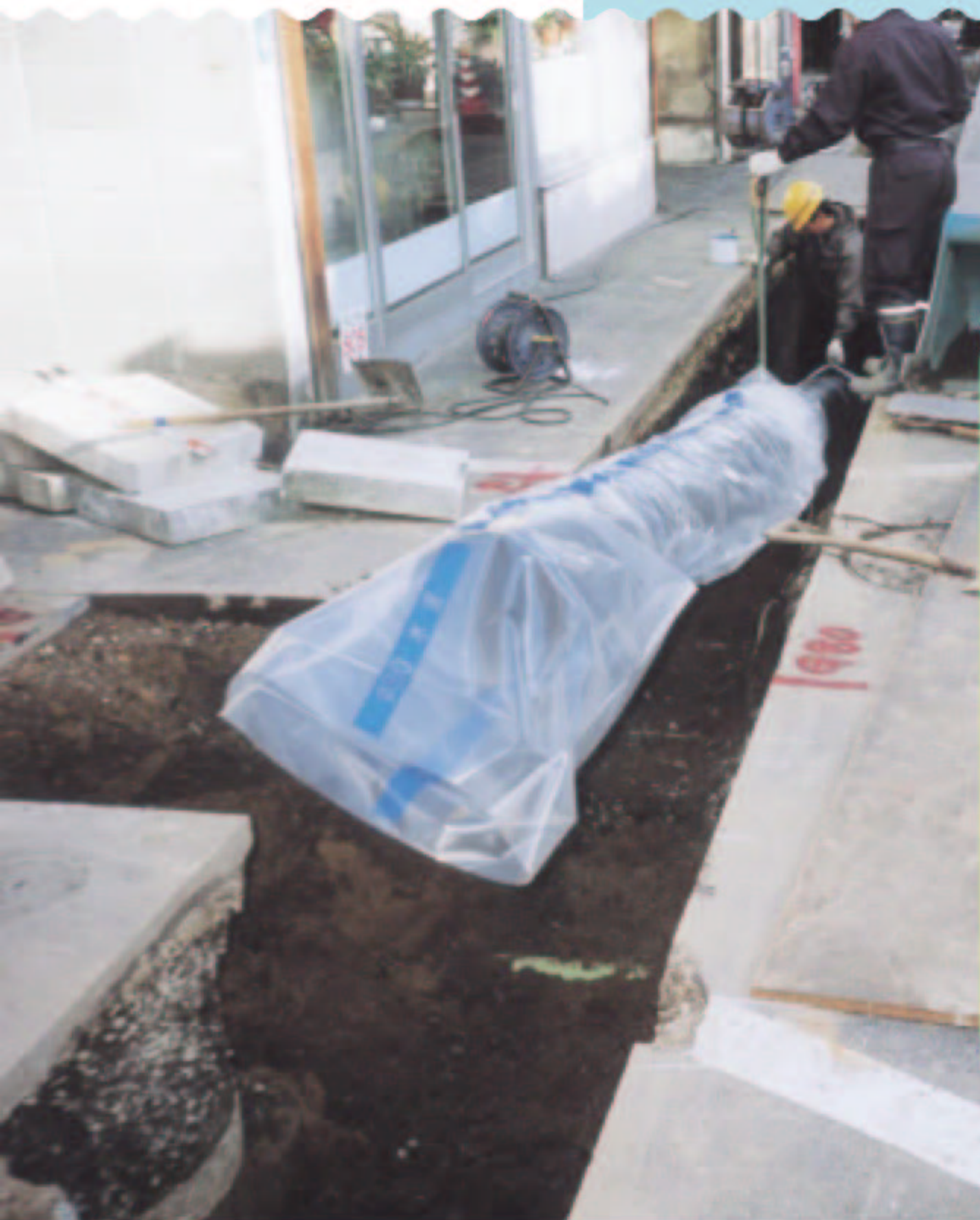
写真は、栗林町内での口径300mmの老朽配水管の布設替え工事の様子です。
