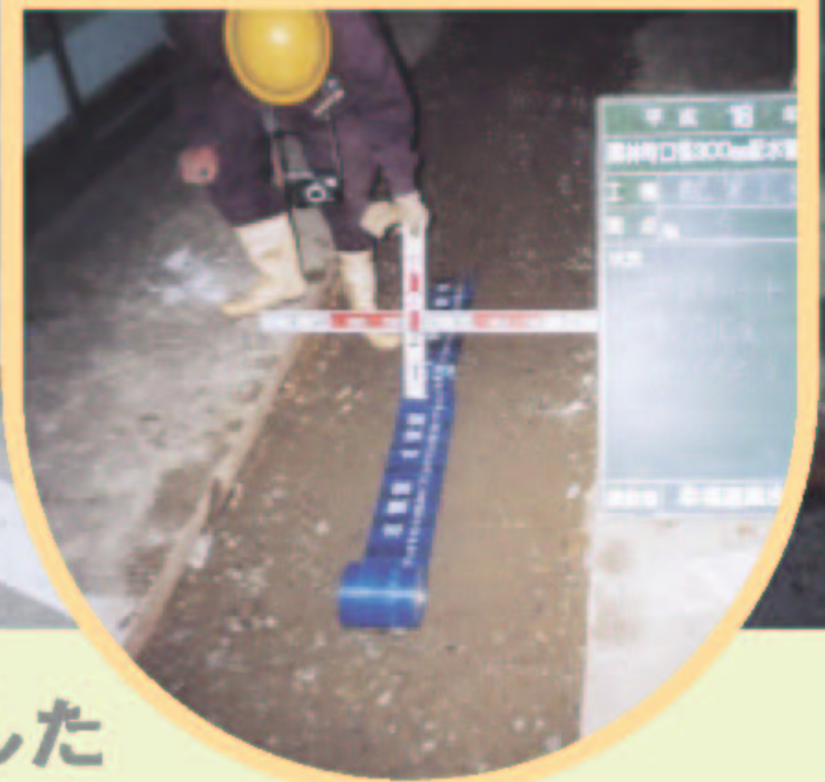
写真は、栗林町内での口径300mmの老朽配水管の布設替え工事の様子です。
