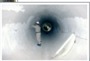
旧築地小学校地下での工事の様子
