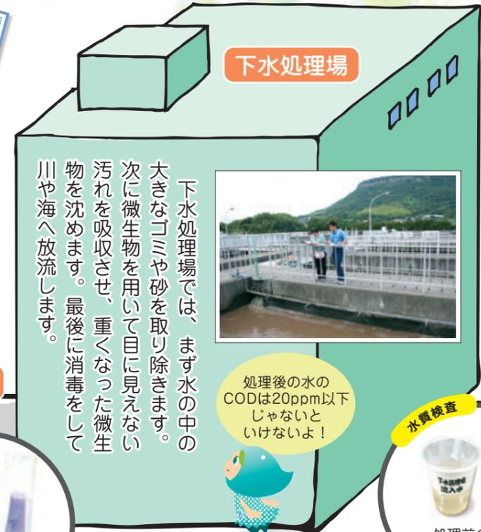
下水処理場では、まず水の中の大きなゴミや砂を取り除きます。次に微生物を用いて目に見えない汚れを吸収させ、重くなった微生物を沈めます。最後に消毒をして川や海へ放流します。
