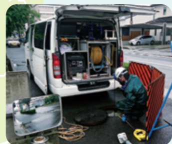
▲工事の事前調査の様子
