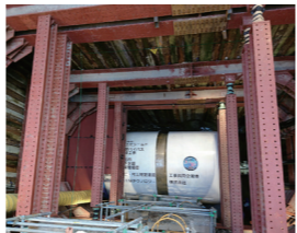
▲立坑の築造現場
