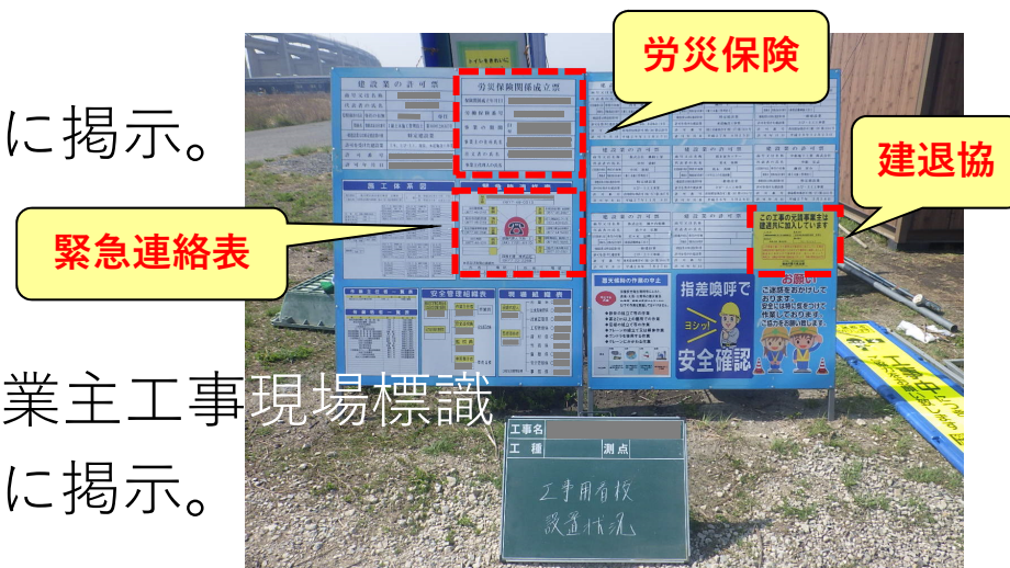
工事看板設置状況
