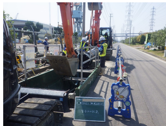
施工状況（管吊込み状況）
