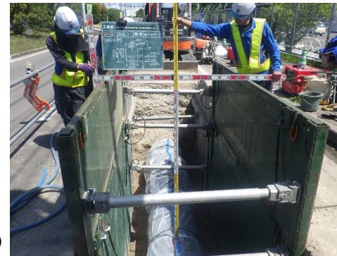
管渠布設工の出来形測定状況
