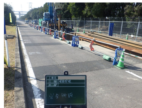
安全管理状況（安全施設設置状況）
