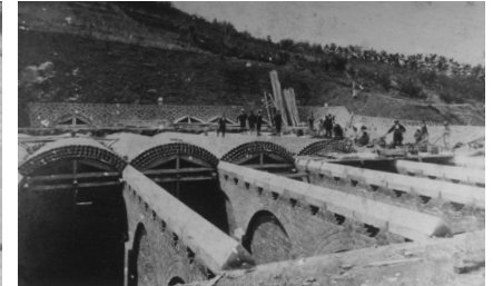
▲西方寺配水池築造工事
