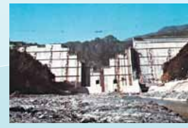
▲建設中の早明浦ダム
