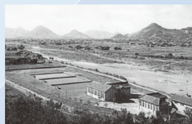
▲香川県で初めて建設された御殿浄水場
