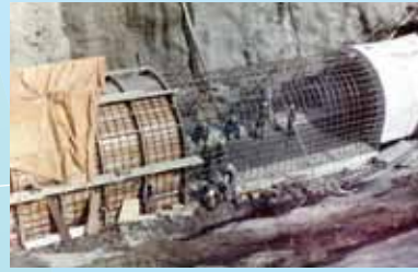
▲建設中の香川用水
