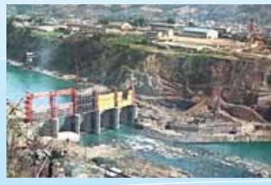
▲建設中の池田ダム
