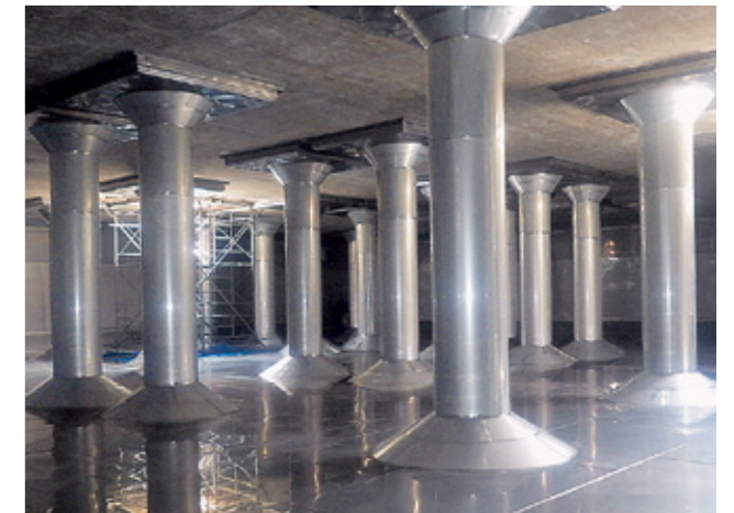
耐震化が完了した浅野浄水場 緩速系配水池の内部
