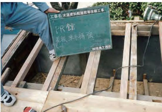
PR館 屋根 垂木腐朽箇所補強
