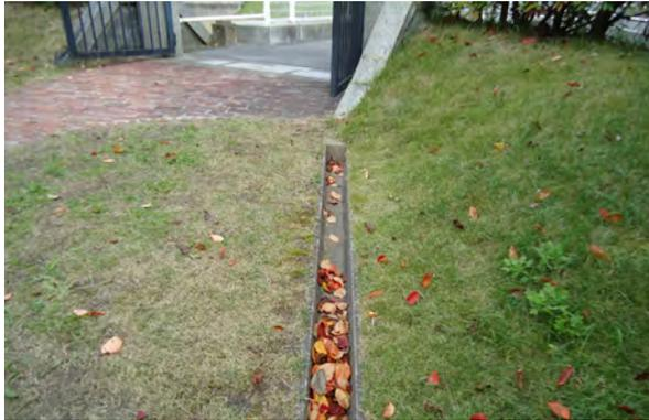
写真 3-55 側溝の落葉堆積
