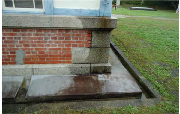
写真 3-59 雨水縦管の未設置
