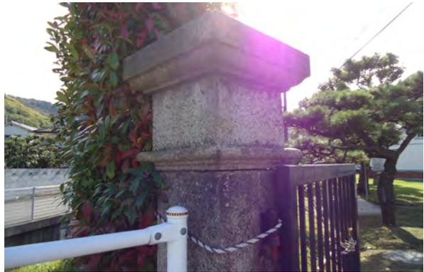
写真 3-30 花崗岩製門柱、柱頭のずれ
