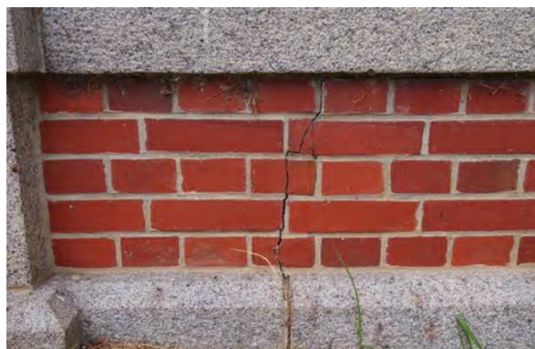
写真2-2 PR館（旧事務室）煉瓦基礎部分の亀裂
