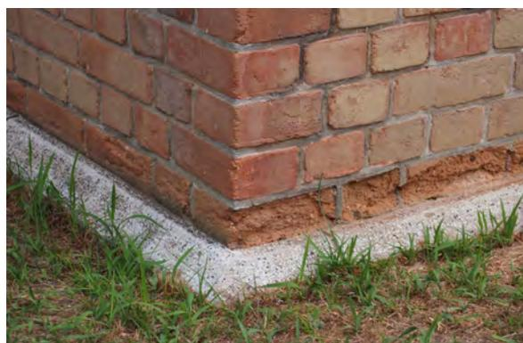
写真2-1 雨水跳ね返りによる煉瓦の浸食
