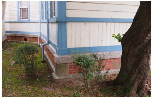
写真 2-9 PR館（旧事務室）根害による軸部の歪み
