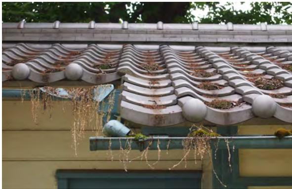
写真 2-7 PR館（旧事務室）雨樋の機能不良
