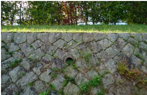
写真 3-57 水抜孔の排水不良
