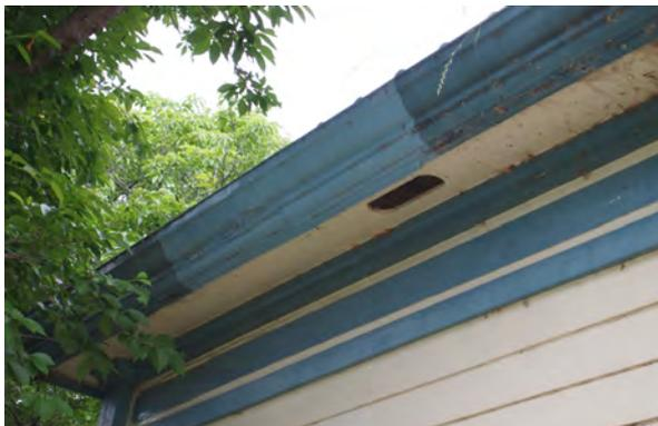
写真 2-6 PR館（旧事務室）軒先の腐朽（修理後）
