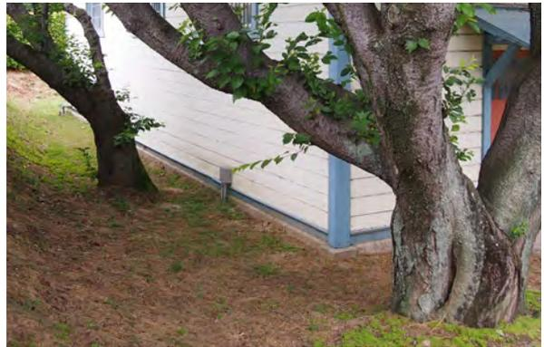
写真 2-10 資料保管庫（旧倉庫）樹木根の基礎下部への潜り込み
