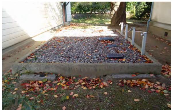
写真 3-39 水道メーター交換練習用工作物
