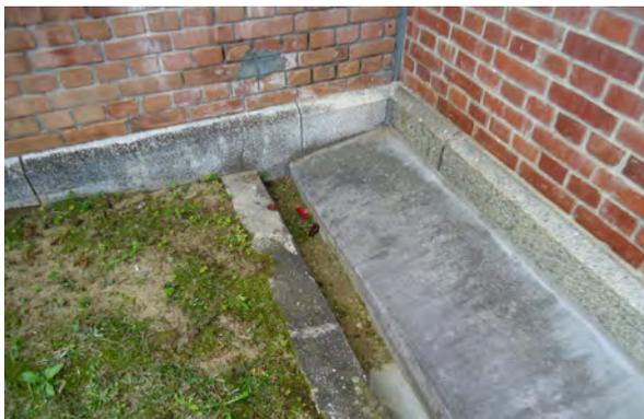
写真 3-58 増築による側溝の寸断
