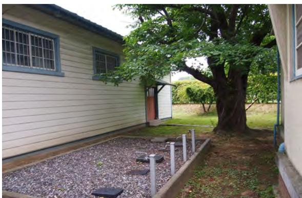
写真 5-22 水道メーター交換練習用工作物
