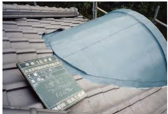
PR館 屋根 銅板葺のうえ、塗装完了
