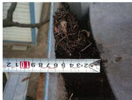
写真 3-1)-2 旧事務所軒先と軒樋
