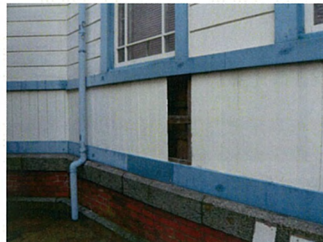
写真 3-1)-35 ⑤豎羽目板解体状況
