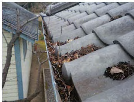
写真 3-1)-1 旧事務所軒先状況
