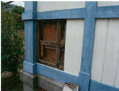
写真 3-1)-28 ②縦羽目板解体状況
