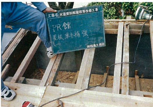
PR館 屋根 垂木腐朽箇所補強
