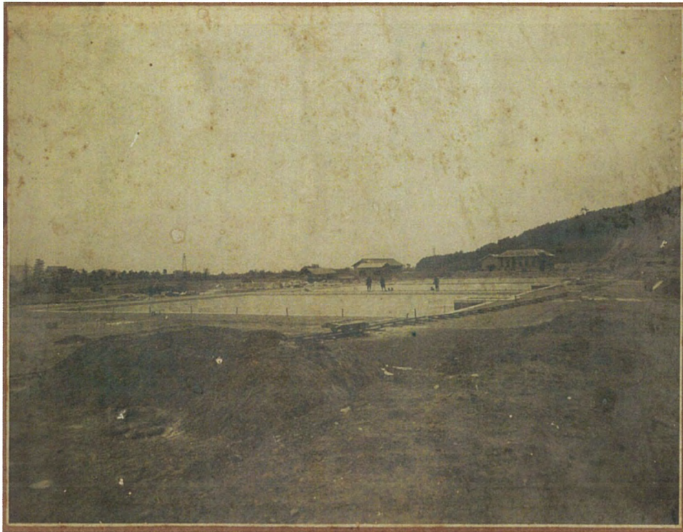
写真 6-1)-1 第六號 高松市水道濾過池ノ全景 大正七年一月十三日撮影
