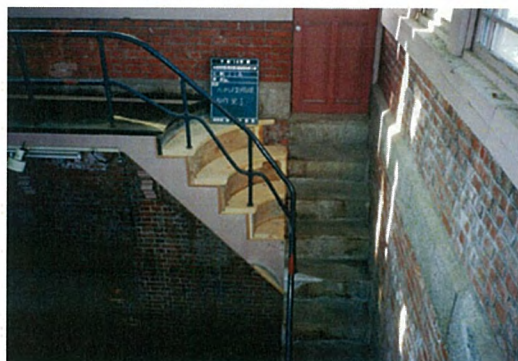
歴史館 西側木製階段一部取替
