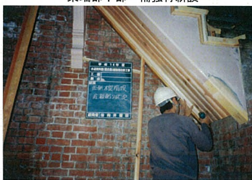
歴史館 西側木製階段一部取替
