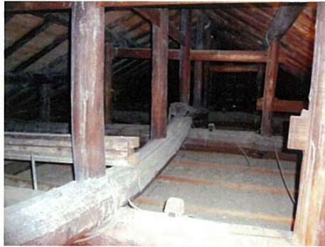
写真 3-1)-8 小屋裏の状況
