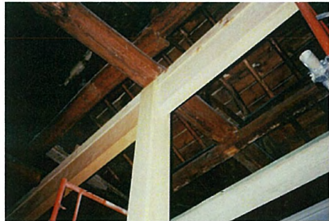
PR館 梁・化粧柱新設
