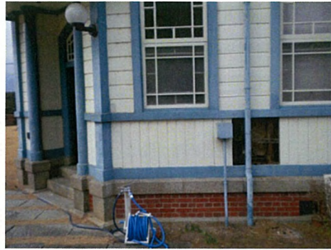
写真 3-1)-31 ③豎羽目板解体状況
