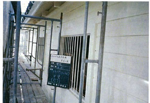
倉庫 塗装（中塗状況）
