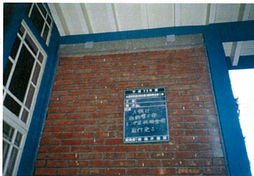
歴史館 レンガ梁 補強金物新規取付
