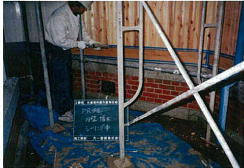
PR館 外壁板・幅木取替
