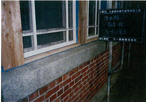
歴史館 敷居 柱取替・シーリング
