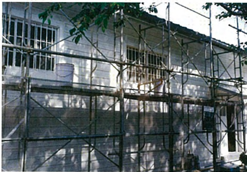
倉庫 塗装（下塗状況）
