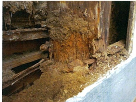
写真 3-1)-33 ③大壁内状況
