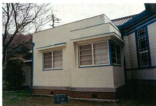
PR館 資料室2 水洗い・下地処理の上リシン吹付
