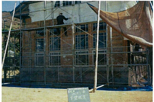
歴史館 剥離・ケレン状況
