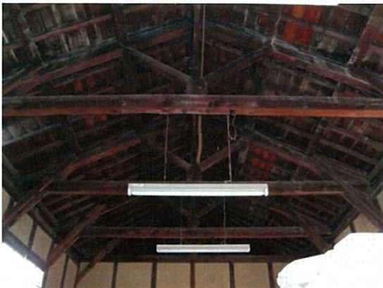
写真 1-4)-11 南側保管庫内部
