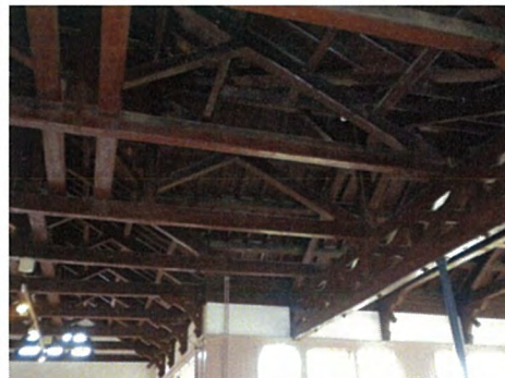
写真 3-1)-11 展示室上部トラス
