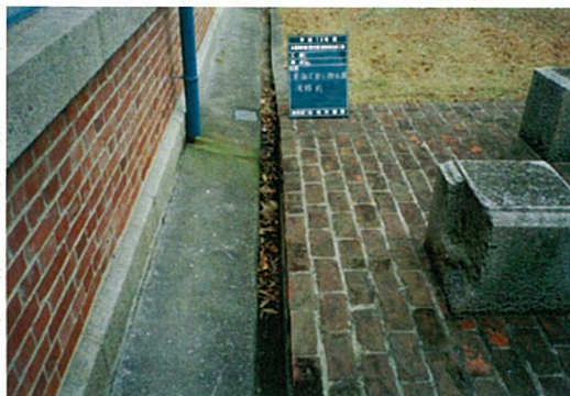
歴史館 犬走り・排水溝 着工前
