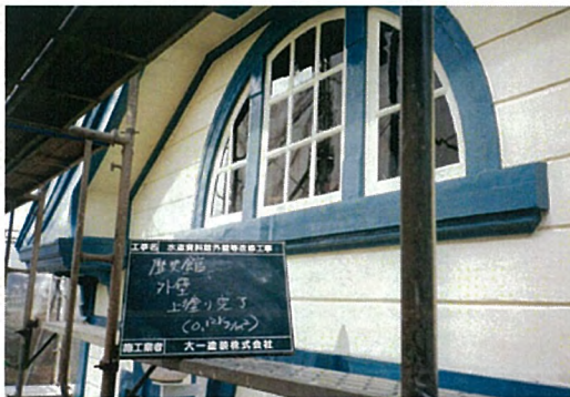
歴史館 外壁 塗装（上塗り）
