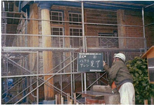
歴史館 剥離・ケレン状況
