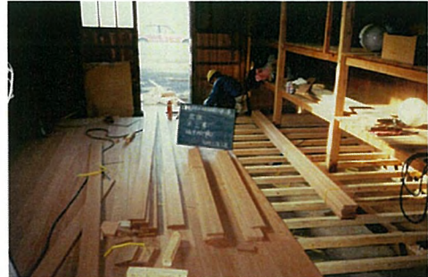
倉庫 上げ床新設
