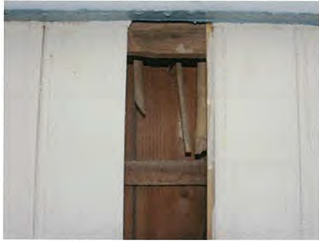
写真 3-1)-38 ⑤大壁内状況
