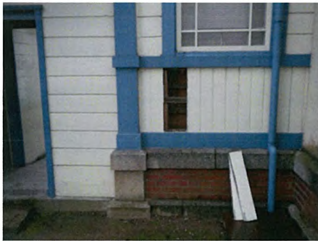
写真 3-1)-26 ①縦羽目板解体状況
