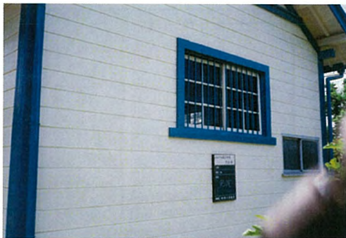
倉庫 塗装（上塗状況）
