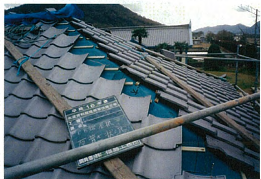
PR館 瓦葺き状況
