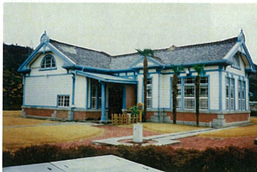
歴史館 屋根葺替前
