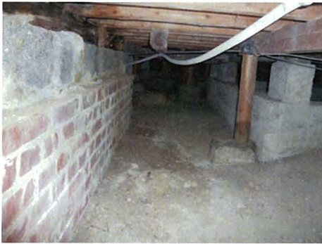
写真 3-1)-23 資料室 3 床下の状況
