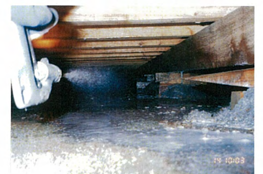
倉庫 床下 乳剤の噴射散布
