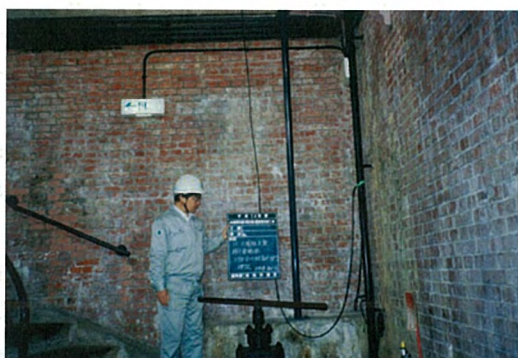
歴史館 1F点検用木製廊下 東端部下部 補強材新設
