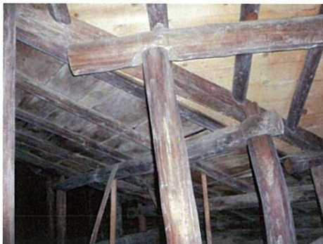
写真 3-1)-6 当初の野地板
