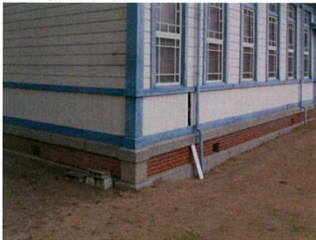
写真 3-1)-34 ④豎羽目板解体状況
