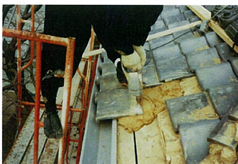
PR館 軒樋取替及び瓦復旧
