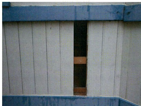
写真 3-1)-37 ⑥豎羽目板解体状況
