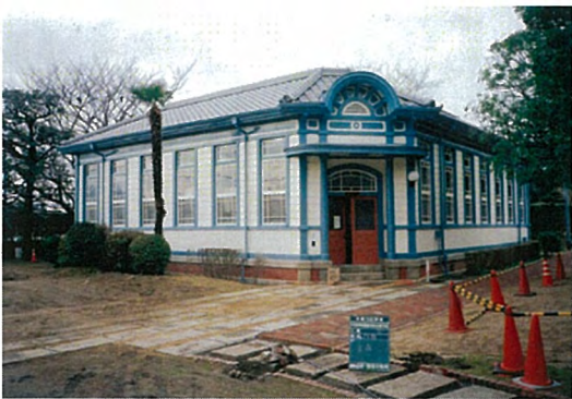
PR館 屋根葺替完了
