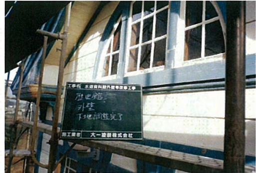
歴史館 外壁 塗装（下地調整）
