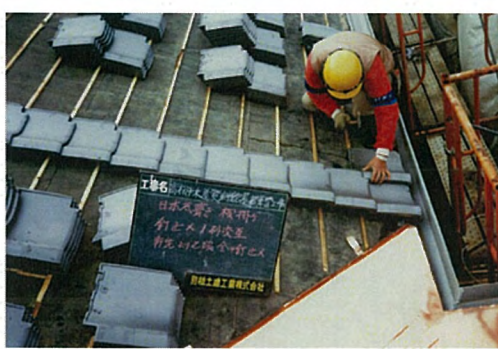
歴史館 葺替状況
