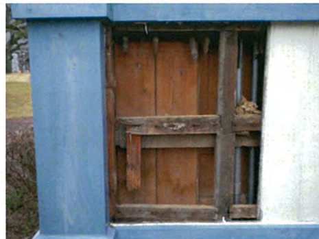
写真 3-1)-29 ②大壁内部状況
