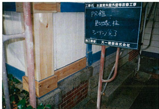
PR館 柱・見切縁等取替・シーリング
