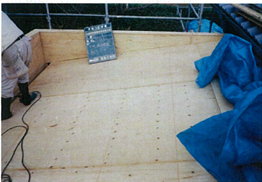
PR館 屋根（資料室2）葺替（下地共）
