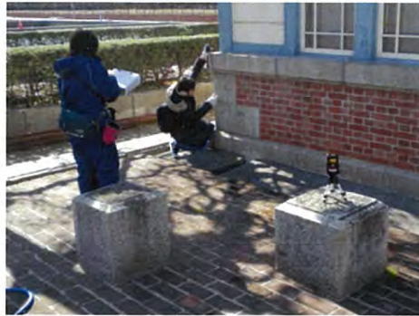
写真 2-5)-1 歴史館 (旧ポンプ室) 東面不陸調査状況
