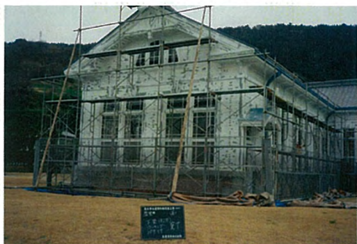
歴史館 塗装（下塗り状況）
