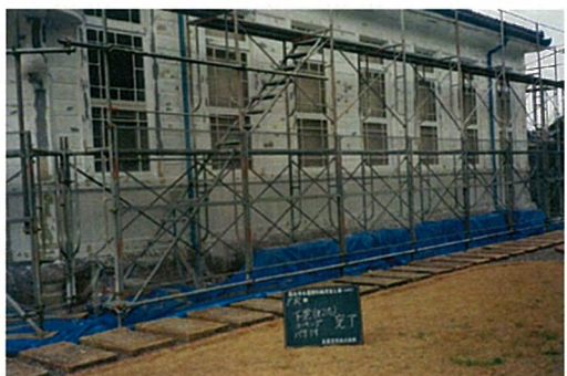
PR館 塗装（下塗り状況）
