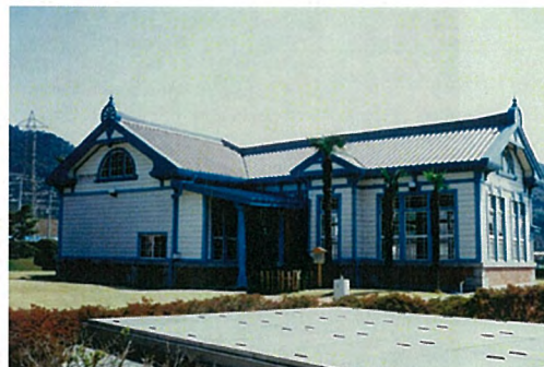
歴史館 屋根葺替完成
