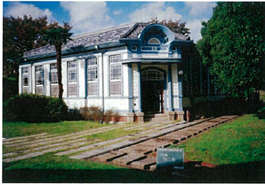
PR館 屋根葺替 着工前
