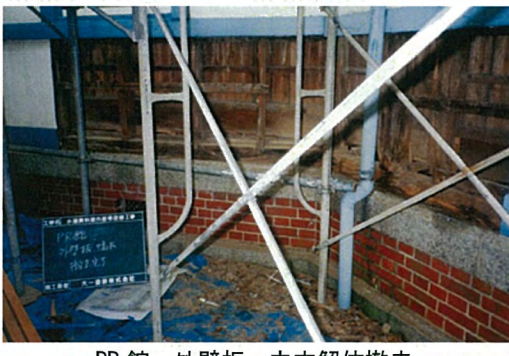
PR館 外壁板・巾木解体撤去
