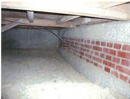
写真 3-1)-17 資料室2（増築部） 増築部と当初建物との取り合い部
