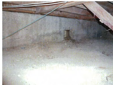
写真 3-1)-18 資料室2（増築部） 増築部のコンクリート基礎
