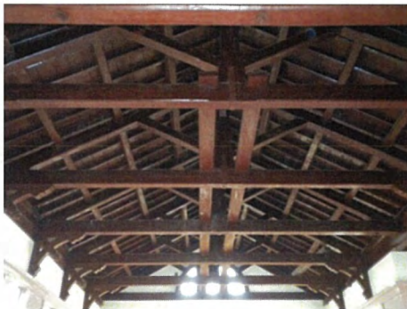
写真 3-1)-10 ポンプ室上部トラス
