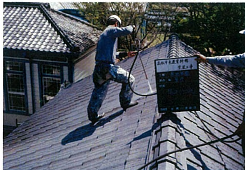
倉庫 屋根 高圧洗浄
