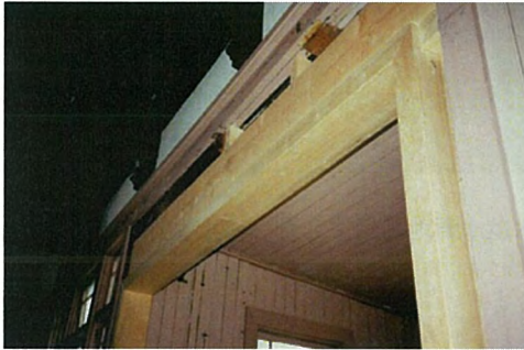
歴史館 荷受梁・三方杵新設
