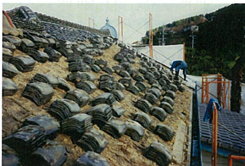
歴史館 瓦撤去状況
