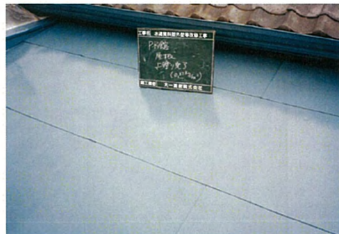
PR館 屋根 塗装
