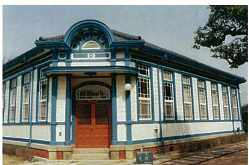
PR館 塗装（完了）
