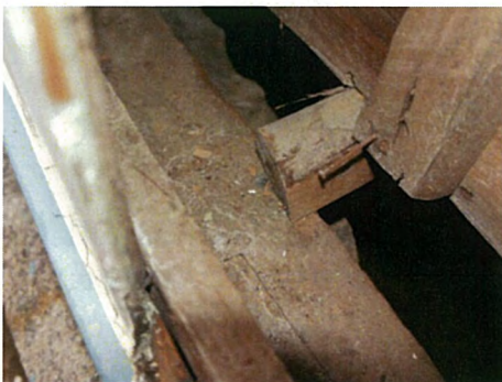
写真 3-1)-36 ⑤大壁内状況
