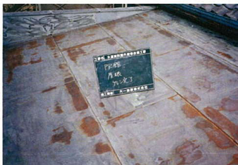
PR館 屋根 ケレン
