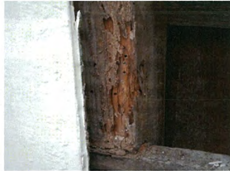
写真 3-1)-27 ①大壁内部状況
