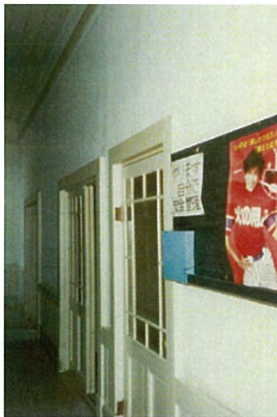
PR館 着工前内部状況
