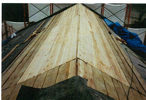
歴史館 野地板貼り状況
