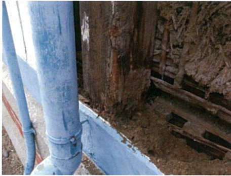
写真 3-1)-32 ③大壁の柱状況
