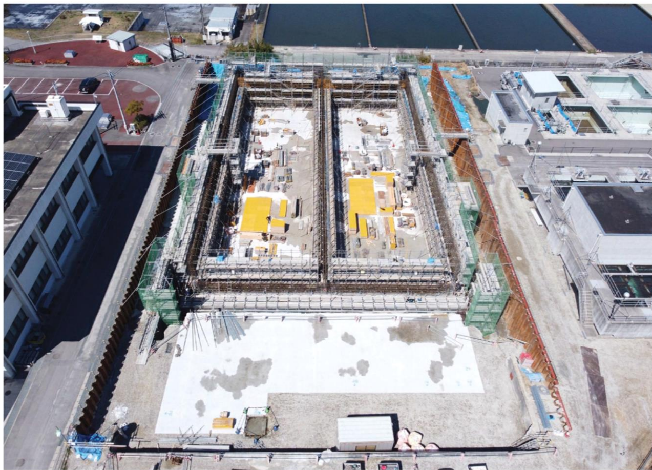
浅野浄水場沈殿池改修工事
